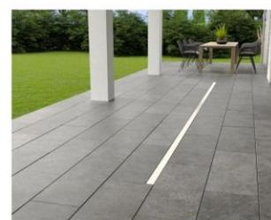
Lichtlinien Profil eingebaut in Plattenbelag
